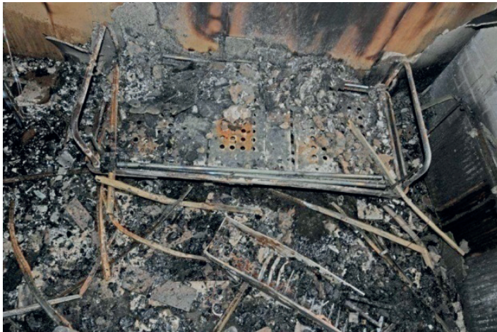
Figuur 12: Foto van de brandruimte met het verbrande bed: de matras is geheel 'opgebrand'
